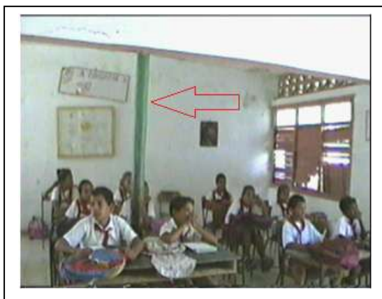
Foto. 5. Estructuras metálicas apuntalando elementos estructurales en locales que se usan como aulas para la educación primaria
